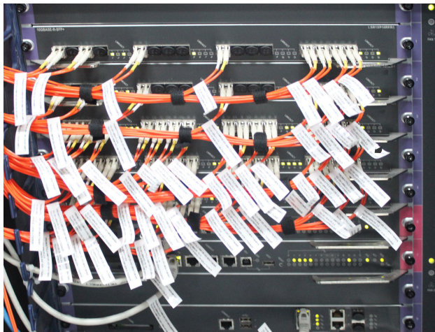
图B-5 光纤布放与绑扎示意图
