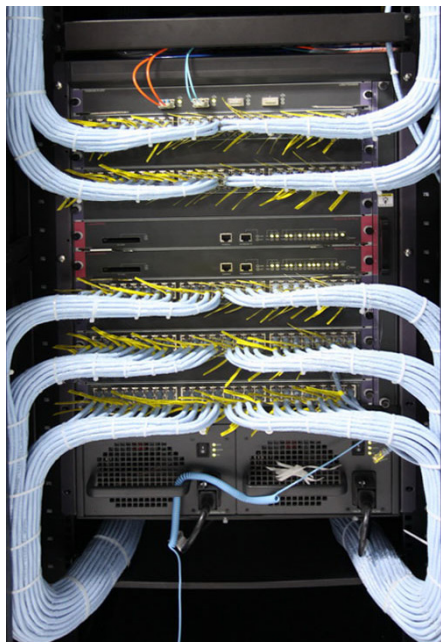
图B-4 网线布放与绑扎示意图
