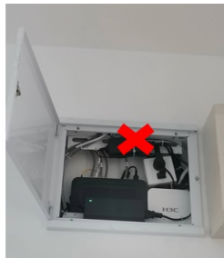
AP安装在金属柜子中，柜门关闭后，信号极差
