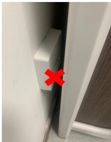
AP被宿舍床体严重遮挡，信号衰减明显
