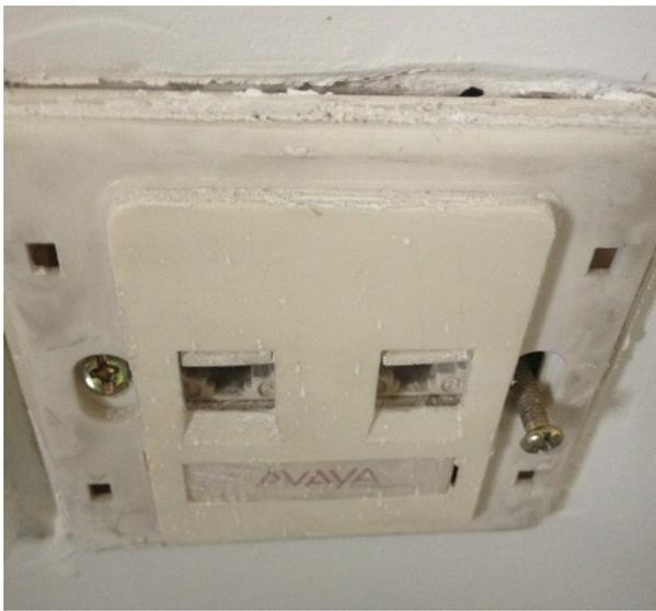
86mm面板背面的这种接口不可以无损拆卸，必须剪断，
