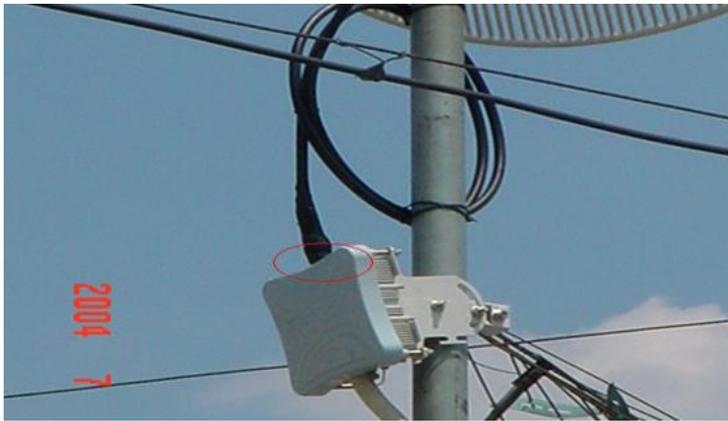
图4 天馈接头进水问题图示
